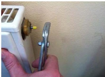
Schritt 4: Thermostatventil wieder anschrauben
